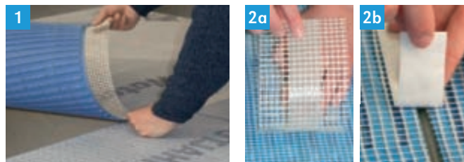
Fig. 1 Relier les nattes avec le treillis dépassant sur les côtés.
