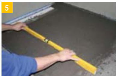
5 La fixation solide et définitive est obtenue une fois le corps du caniveau scellé dans la chape. Les bandes de rive AquaDrain® avec pied SK évitent les ponts acoustiques. Réaliser la chape dans les règles de l'art, sur toute la surface du sol.
