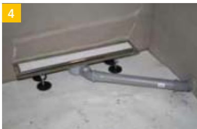
4 Raccorder le siphon du caniveau de douche au tuyau d'évacuation DN 50.
