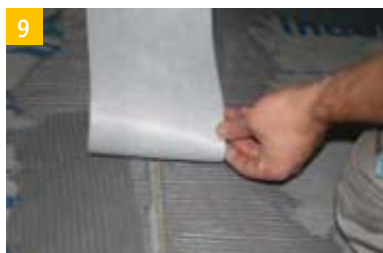
9 L'étanchéité des joints de dilatation est assurée par les rubants de dilatation IndorTec® SEAL-BW. Une adhérence optimale est obtenue au bout de 3 à 4h avec la colle d'étanchéité IndorTec® SEAL-DK.
