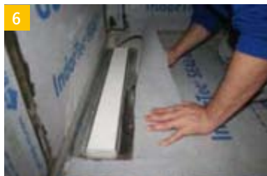
6 Découper la bande d'étanchéité composite IndorTec® SEAL et la fixer sur le sol de la douche avec le mortier-colle carrelage.
