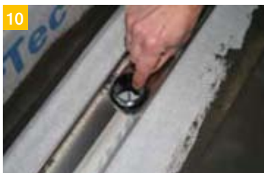
10 Pour contrôler et nettoyer le siphon, relever le cache et extraire le dispositif anti-odeur.
