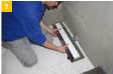
2 Le caniveau peut être raccordé directement. Le pivotement libre du siphon garantit en outre un montage libre.
