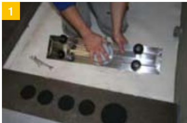
1 Monter le siphon et les pieds réglables.
