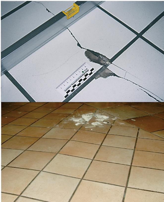
Les contraintes au cisaillement dues à des coefficients de dilatation différents du revêtement et du support ou en raison de chapes récentes encore en rétraction conduisent à des fissures ou bombements du revêtement.
