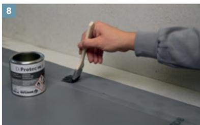
DiProtec® SDB Bahnen und DiProtec® AB-K Dichtbänder werden im einzudichtenden Bereich mit DiProtec® PR-DB grundiert. Trocknungszeit/überarbeitbar ca. 30 Min., bei 21° C.
