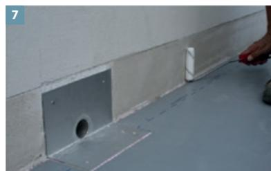
Kommt am Wandanschluß das Sockelprofil Pro® Fin SP nicht zur Anwendung, sind die Wandbaustoffe mit geeigneten Spachtelmassen zu glätten und nach Abtrocknung mit DiProtec® PR-ZE Primer zu grundieren.
