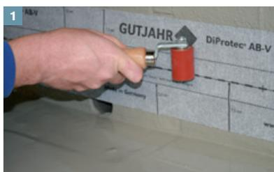
1 Nach Erhärtung des DiProtec® FLK ist es möglich das Abdichtungsband DiProtec® AB-V aufzukleben...
