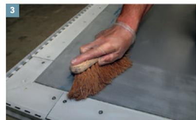
Alle Metalleinbauteile sowie DiProtec® SDB Bahnen und DiProtec® AB-K Bänder und Ecken sind gründlich anzuschleifen, mit mind. 80er Korn oder gröber. Metallteile müssen rostfrei sein. Holz, z.B. Rahmen von Türen und Fenster, sind restlos frei von Lacken zu schleifen. Die Anschlifffläche auf den Untergründen ist grundsätzlich größer als die nachfolgende Grundierung zu erstellen.
