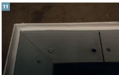
Zu schützende Bauteile, die nicht mit Flüssigkunststoff bearbeitet werden sollen, sind ebenfalls mit Klebeband zu sichern.
