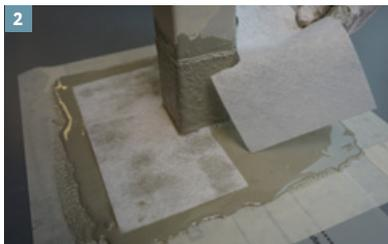
2 Anschließend ist der Manschetten-Zuschnitt mit Flüssigkunststoff deckend zu überarbeiten. Den zweiten Manschetten-Zuschnitt einlegen und mit Flüssigkunststoff überarbeiten.
