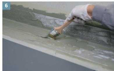
Im zweiten Arbeitsgang sind die Vlieseinlagen mit Flüssigkunststoff deckend zu überarbeiten. (ca. 1/3 der Menge)
