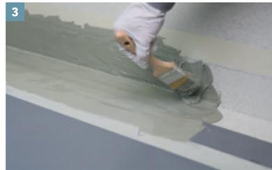
Den Flüssigkunststoff anschließend mit dem mitgelieferten Pinsel auftragen. (ca. 2/3 der Menge)
