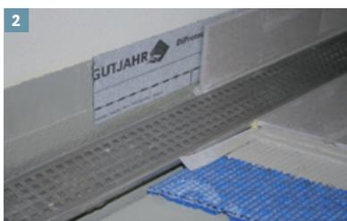
2 ... um den Untergrund bspw. zur Verklebung eines Fliesensockels herzustellen. Dies dient zum Schutz der hochgeführten Abdichtung vor mechanischen Beschädigungen.
