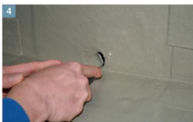
4 Nach Erhärtung, sind an Bodenabläufen/Speiern die DiProtec® FLK-AV Anschlußvliesmanschetten aufzuschneiden.
