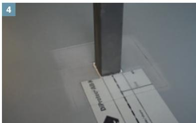
Metalloberflächen werden mit DiProtec® PR-MT Primer gereinigt. Hierzu einen Teil des FLK Vliesstreifens mit MT-Primer tränken und die Metalloberfläche reinigen.
