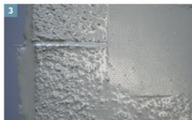
Dünnschichtige Belagsverlegungen auf WatecDrain® KP+ /3E erfordern, dass Überlappungen der Vlieseinlagen vermieden werden. In diesem Fall, sind die Vlieseinlagen stumpf zu stoßen und diese mit DiProtec® FLK-ST Stoßarmierung zu sichern. In einem weiteren Arbeitsgang ist die ST Stoßarmierung mit Flüssigkunststoff zu überarbeiten.
