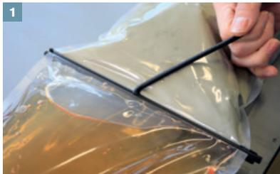
Trennstab des Flüssigkunststoffgebindes entfernen und 2–3 Min. kneten, bis ein einheitlicher Farbton erreicht ist. Von nun an beträgt die Verarbeitungszeit bei 21°C Umgebungstemperatur ca. 30 min.
