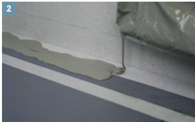
Schutzhandschuhe anziehen und Flüssigkunststoff aus dem Knetbeutel heraus verarbeiten oder in ein sauberes Gefäß einfüllen.
