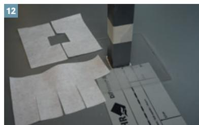
DiProtec® FLK Vliesstreifen (alternativ DiProtec® FLK-AV Anschlussvliesmanschette) entsprechend der Einbausituation zuschneiden. Siehe hierzu Übersicht Zuschnitte auf Seite 6.
