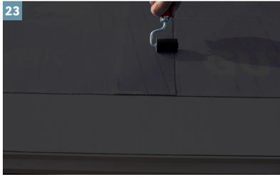
Entsprechend den Regelwerken sind auch bei KSK-Bahnen die Verklebungen mit mindestens 10 cm Überlappung auszuführen.
