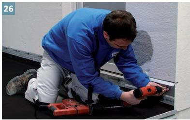
Dann wird das Profil eingeschoben und im Untergrund verdübelt. Die Profilnase stellt sicher, dass Fassadenwasser die Abdichtung nicht hinterlaufen kann.
