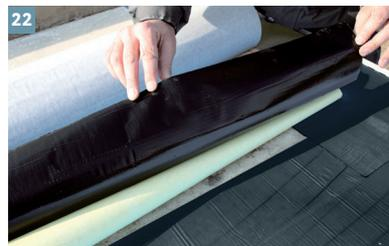
Bahn umschlagen, Silikonpapier abziehen und DiProtec® KSK Bahn ausrichten. Ca. zur Hälfte umschlagen/klappen und unter gleichmäßigen Druck auflegen. Bahnen blasenfrei verkleben.
