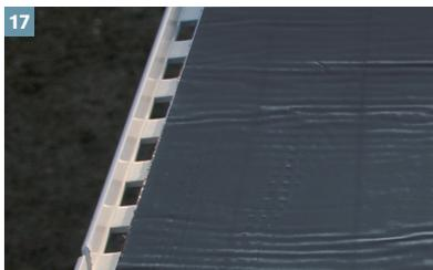
Direkt an den Drainlochstanzenungen der Abschlussprofile ansetzen.
