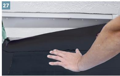
In einem letzten Arbeitsschritt wird das KSK-AB Abdichtungsband auf das Sockelprofil aufgeklebt. Auch hier ist auf eine 10 cm Überlappung auf der DiProtec® KSK Bahn zu achten.
