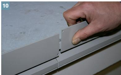
Das Aufstecken des ProFin® BL Blendenprofils, bzw. des Aufkantungsclips auf das ProFin® DP Basisprofil erfolgt unmittelbar vor der Belagsverlegung.
