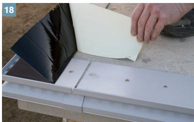
Jetzt die hintere Hälfte umklappen, Silikonpapier abziehen und DiProtec® KSK-AB Abdichtungsband blasenfrei ankleben.
