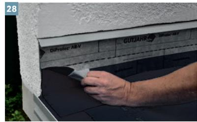
Zur Erstellung eines normgerechten Boden-/Wandanschlusses (welcher auch verputzbar bzw. verfliesbar ist) ist das DiProtec® AB-V Trägerband auf/über die DiProtec® KSK Bänder zu kleben...
