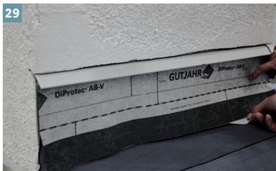
– zur Vermeidung kapillaren Wasseraufstiegs an aufgehenden Bauteilen (Dochtwirkung in der Vliesebene) wird das DiProtec® AB-V Band so angesetzt, dass die Unterkante Vlieskaschierung über Oberkante fertiger Oberbelag positioniert ist. Hierbei ist auf eine Überlappung zu DiProtec® KSK-AB von mind. 10 cm zu achten.
