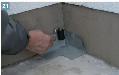
Die Ausführung von Innen- und Außenecken erfolgt mit den selbstklebenden Fertigecken DiProtec® AB-K Innenecke bzw. Außenecke. Diese werden vor der Verklebung der Flächenbahn verlegt.
