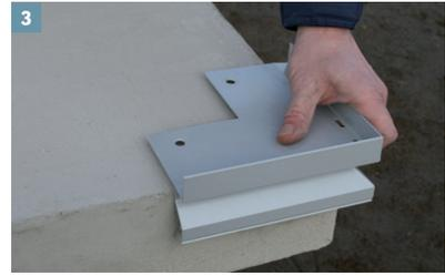
DiProtec® FIX-MSP auf der Profilunterseite wie unter Bild Nr. 2 in Streifen auftragen und die Eckprofile auf den Estrich aufsetzen und ausrichten.
