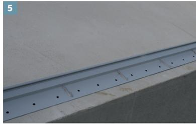
Im maximalen Abstand von 3 Lochungen DiProtec® FIX-MSP auftragen, Profile ansetzen und ausrichten.
