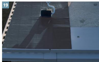
Nach dem vollständigen Aufkleben wird das komplette DiProtec® KSK-AB Abdichtungsband mit einer Andruckrolle vollständig überarbeitet. Die weiteren DiProtec® KSK-AB Abdichtungsbänder wie...
