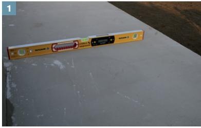
Die Oberflächen von Balkonen/Terrassen müssen ein Gefälle zu den freien Rändern oder zu den vorgesehenen Bodenabläufen aufweisen: mind. 1% für die AquaDrain® Flächendrainagen. Die Watec® Dünnschichtdrainagen sind auf KSK-Bahnen nicht zulässig.
