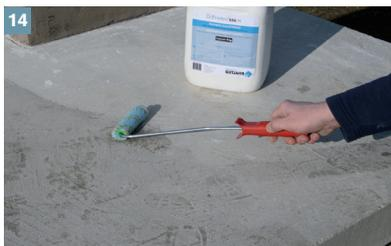
Grundierung der abzudichtenden Flächen, Boden und Sockelbereich mit DiProtec® PR-ZE. Die Folgearbeiten erst nach ca. 2 Std. Ablüftezeit beginnen (Fingerprobe).
