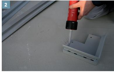
Die Randprofilmontage beginnt mit den Ecken. Hierzu werden alle Profile und Zubehörteile mit DiProtec® FIX-MSP am Untergrund vor der Verdübelung fixiert.
