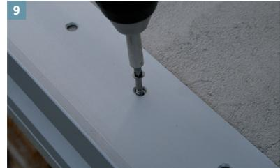
Zum Schluss werden die Profile mit den mitgelieferten Edelstahlschrauben befestigt.
