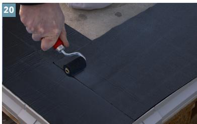
...unter Bild Nr. 16 bis 19 beschrieben ankleben. An Überlappungsstößen sind die Nahtstellen nochmals sorgfältig mit dem Andruckroller zu überarbeiten. Überlappungsbreite = mind. 10 cm
