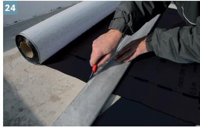
Nach Eindichtung der Randprofile mit der Flächenabdichtung beginnen. Anschließend die DiProtec® KSK Bahnen auslegen und passend zuschneiden.
