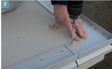
Nach der Fixierung aller Profile mit DiProtec® FIX-MSP erfolgt mit den Ecken beginnend die Verdübelung und Verschraubung der Profile. Steinbohrer  $\varnothing = 8$  mm.
