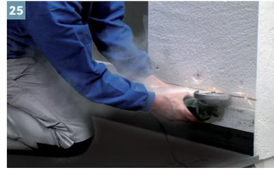
Der Boden-Wandanschluss erfolgt mit dem ProFin® SP Sockelprofil, welches 15 cm über Oberkante fertiger Belag zu positionieren ist. Hierfür wird zunächst die Wand eingeschnitten.
