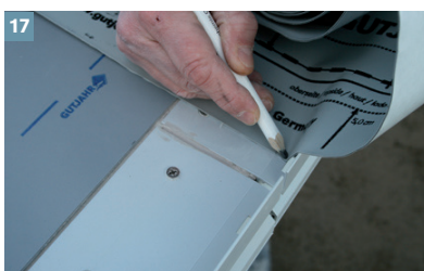
17 Nach dem Auslegen der DiProtec® SDB erfolgt der Zuschnitt der DiProtec® AB-K Abdichtungsbänder.
