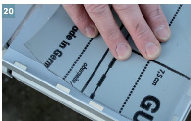
20 Vordere Hälfte zum Teil abziehen und unmittelbar an den Drainlochstanzungen der Abschlussprofile ansetzen.
