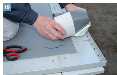
19 Begonnen wird immer an der vordersten/ tiefst gelegenen Traufkante. Zum einfachen Ankleben sind die Abdichtungsbänder mit einer 2-geteilten Silikonfolie ausgestattet.
