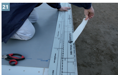
21 Zug um Zug die vordere Hälfte der Silikonfolie abziehen und das DiProtec® AB-K Abdichtungsband blasenfrei andrücken.
