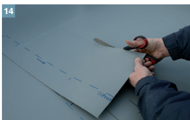
14 Die DiProtec® SDB auslegen und mit ca. 3 – 5 mm Abstand einmessen und zuschneiden.
