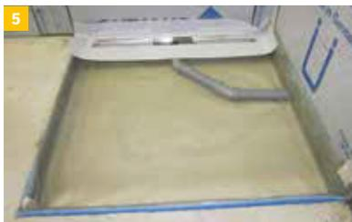
5 Abflussrohre DN40 an die Duschrinne anschließen. Ein Mindestgefälle von 1 % ist einzurichten. Ein etwaiger Adapter DN40/DN50 ist an die bauseitige Abwasser-Installation unmittelbar vor dem Wandanschluss zu montieren. Ggf. sind die Rohre mit einer Schallsisolierung zu ummanteln.
