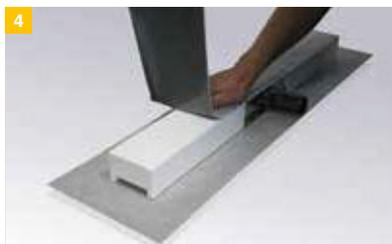
4 Vor dem Setzen der Rinne wird unterseitig Klebemörtel aufgetragen um eine Verkrallung zum Estrichmörtel, bzw. um eine vollflächige Auflage sicherzustellen. Insbesondere zum direkten Verkleben kann ein Aufzahn zweckmäßig sein.
