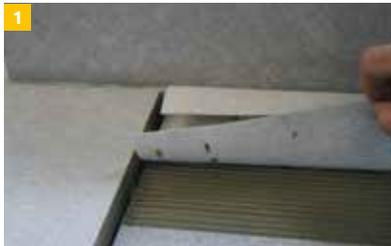
1 Die dichte Einklebung von Dichtmanschette an Boden ...
