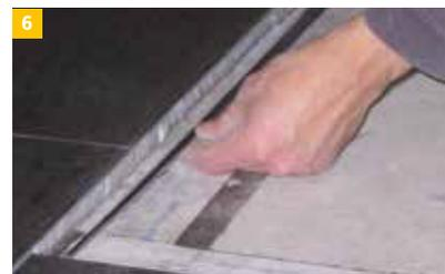
6 Nach Verfliesung des umfassenden Bodenbelages am Duschbereich, das Gefälleprofil entsprechend ablängen und mit DiProtec® FIX-MSP Dicht-Klebstoff an der/den freien seitlichen Wangen der Estrichaussparung ankleben. Der wandbündige Einbau ist bei dieser Duschrinne möglich.
