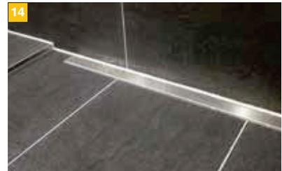
Einlegen der Wendeauflage (Edelstahl- abdeckung oder Fliesenmulde) in den Duschrinnenkörper. Die Fliesen werden mit DiProtect® FIX-MSP in die Fliesenmulde eingeklebt – fertig.
