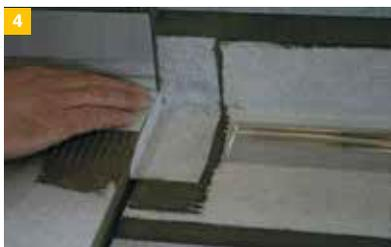
4 ...sowie alle Dichtbänder eingeklebt bis der Duschbereich mit allen Boden- und Wandflächen komplett eingedichtet ist.
