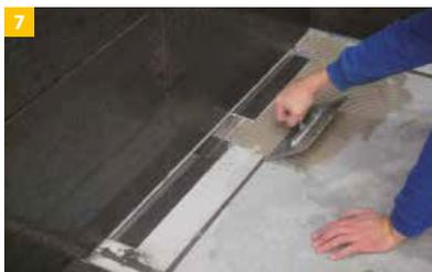
7 Der Einbau des Drainrahmens und die Fliesenverlegung erfolgt Zug um Zug. Klebemörtel vorziehen...
