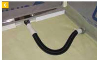
6 Zur schnelleren Montage empfiehlt sich IndorTec® FLEXDRAIN FR Flexrohr mit 75 cm Länge. Der korrekte Rohranschluss und die Wasserableitung sind vor dem Estricheinbau zu überprüfen.
