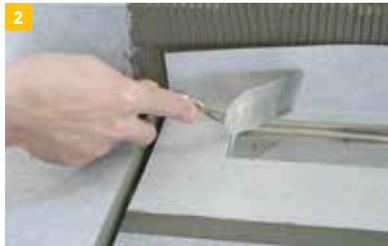
2 ...und Wand erfolgt mit Dichtkleber (z. B. Ardex 7+8 Dichtkleber).
