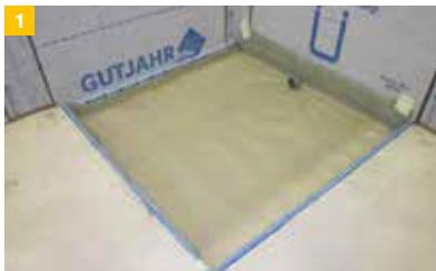
1 Untergrund für Estricheinbau fachgerecht vorbereiten (Randdämmstreifen, etc.)
