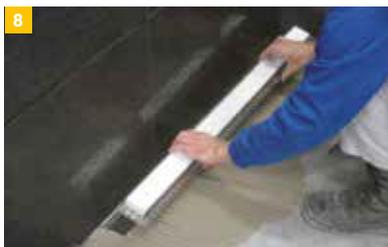
8 ... und FLEX-Drainrahmen mit EPS Füllstreifen (Verbiegungsschutz des Rahmens und Bautenschutzabdeckung) einsetzen. Winklige/parallele Ausrichtung an Fliesenfugen und Wandanschluß sind bis +/- 5 mm möglich.
