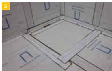
5 Fertig zur Fliesen- bzw. Natursteinverlegung. Wird die IndorTec® FLEXDRAIN auf Podeste eingebaut, muss an allen Rändern ein Aufkantungswinkel (nach ZDB-Merkblatt „Verbundabdichtungen“ eingedichtet werden.
