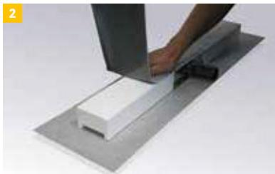
2 Butylband unterseitig auf den Fixbauadapter der IndorTec® FLEXDRAIN Duschrinne aufkleben (Haftbrücke für Klebe-/Estrichmörtel und gleichzeitiger Schallschutz).
