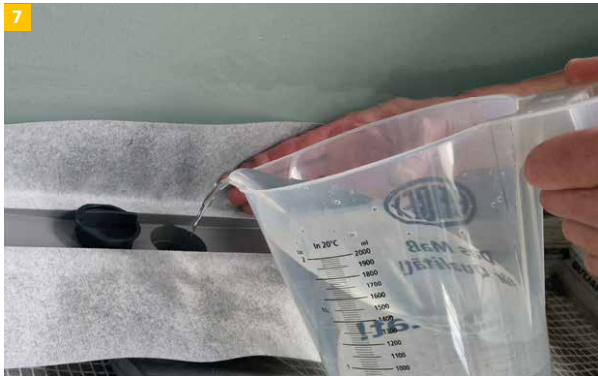
7 Anschließend die Dichtheitsprüfung vornehmen und...
