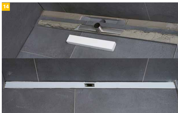
14 Nach der Belagsverlegung wird die Edelstahlabdeckung mit Fliesenkleber auf die erforderliche Höhe eingeklebt...
