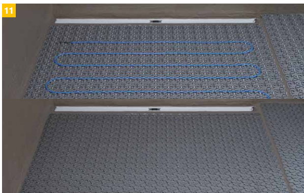
11 Alternativ kann die IndorTec® FLEXBONE-VA als Abdichtung und Entkopplung oder IndorTec® THERM-E als Abdichtung, Entkopplung und elektrische Flächenheizung, im geprüften System, eingebracht werden.
