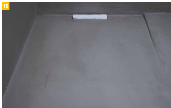
10 Nach Austrocknung des Estrichs die Duschfläche abdichten.
