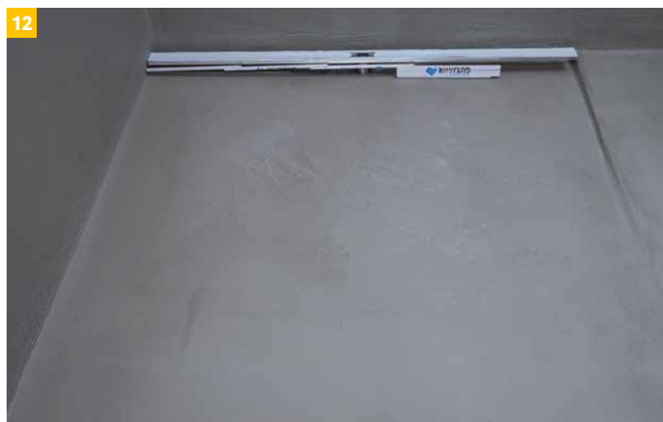
12 Die erforderliche Länge der Edelstahlabdeckung abmessen. Da der Ablauftopf nicht zwingend mittig eingebaut sein muss, ausgehend vom Ablauf die Länge links und rechts getrennt messen...
