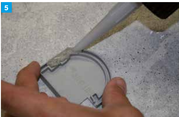
5 Die Rinnenenden werden mit den ProRin® BR Endkappen verschlossen. (DiProtec® FIX-MSP)
