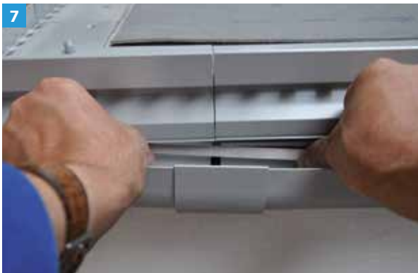
7 ... die ProRin® Rinnenaussteifung im Bereich des Rinnenverbinders in die Einhangnut einlegen ...
