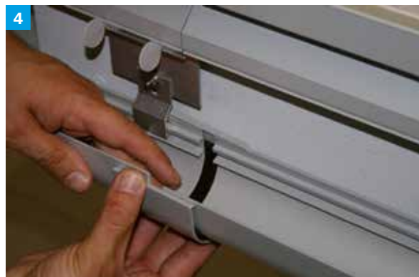
4 Im Stoßbereich benachbarter Balkonrinnen 5 – 8 mm „Bewegungsfuge“ einhalten. Die Rinnenelemente mit ProRin® BR Rinnenverbindern untereinander verbinden.
