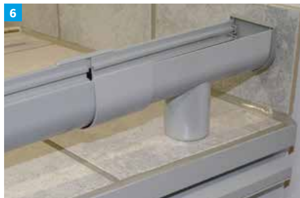
6 Für die Balkonseite mit dem Anschluss der ProRin® BR Balkonrinne an das Fallrohr, das Rinnenablaufelement mit Rinne vormontieren.
