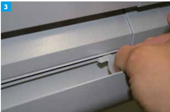
3 ...und mit den Arretierclipsen sichern.
