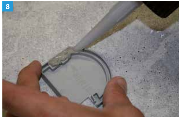
8 Die Rinnenenden werden mit den ProRin® BR Endkappen verschlossen. (DiProtec®FIX-MSP)
