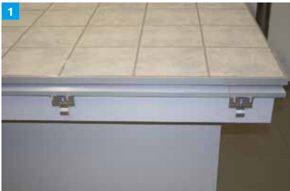
1 An den Balkon-, bzw. Terrassenecken beginnen: Die höhenverstellbaren Rinnenhalter einhängen und mit den Arretierclipsen sichern.
