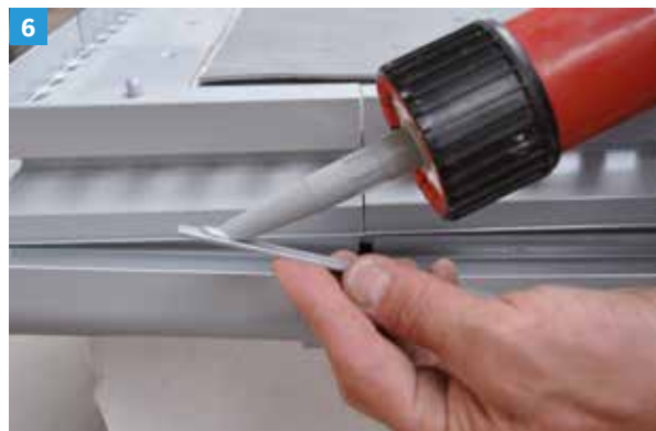
6 ... DiProtec® FIX-MSP auf der beiliegenden ProRin® Rinnenaussteifung auftragen, ...
