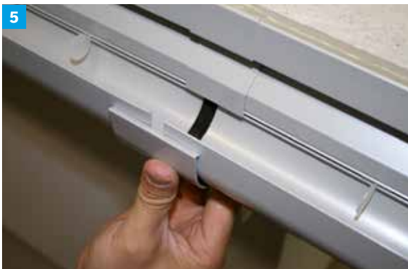
5 Die einzelnen Elemente mit den ProRin® BR Rinnenverbindern zusammenfügen.
