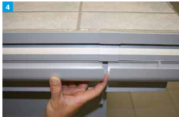
4 Im Stoßbereich benachbarter Balkonrinnen 5 - 8 mm „Bewegungsfuge“ einhalten.
