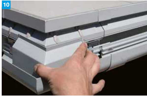
DiProtec® FIX-MSP Streifen im Abstand von 10 – 15 mm auftragen und die ProRin® RB Außenecke in die frischen Klebestreifen eindrücken.
