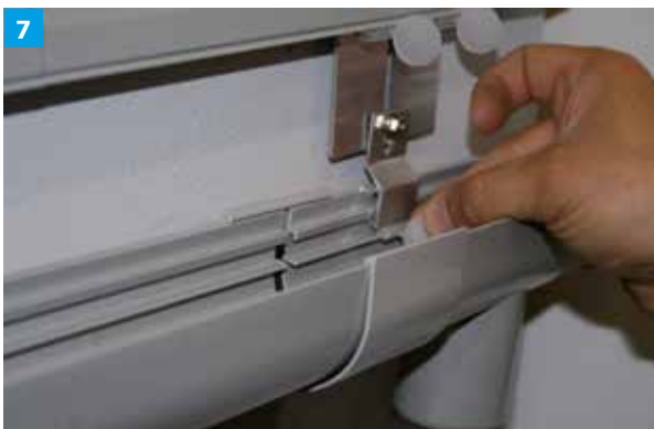
7 ... und dann Rinnenhalter und ProRin® BR Balkonrinne einhängen. Mit Arretierclipsen sichern.
