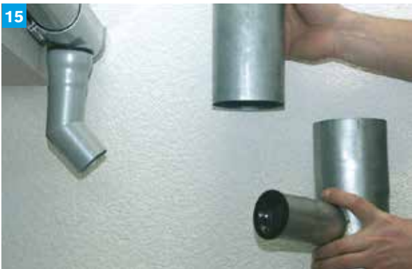
Anschluss der Entwässerung an ein bestehendes Fallrohr mit dem ProRin® AL Fallrohradapter DN 100...
