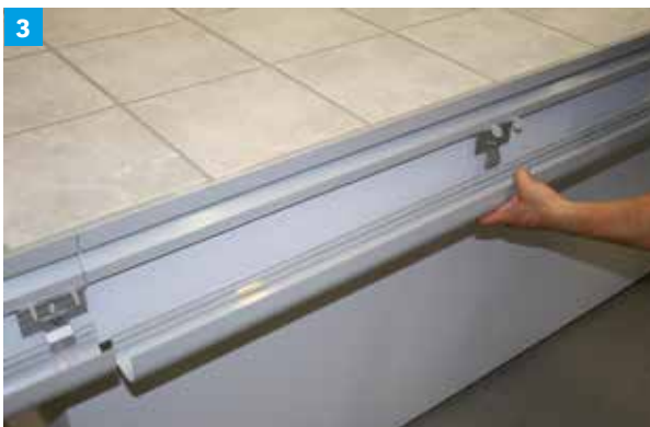
3 Die ProRin® BR Balkonrinnen einhängen und ebenfalls mit den Arretierclipsen sichern.
