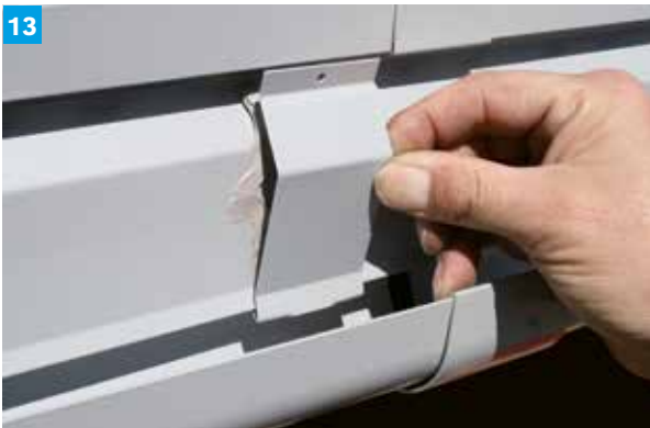
Die Montage der ProRin® RB Profilverbinder erfolgt wie vorher beschrieben.
