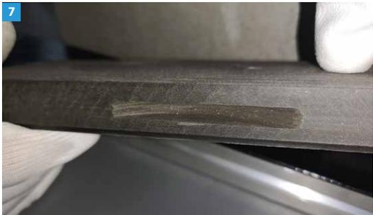
Letzte Terrassendiele mit **TerraMaxx® RS-NKE** Nach Einkürzen der letzten Diele, bündig mit der Unterkonstruktion, wird die Nut mit einer geeigneten Maschine wie im Bild ausgefräst.
