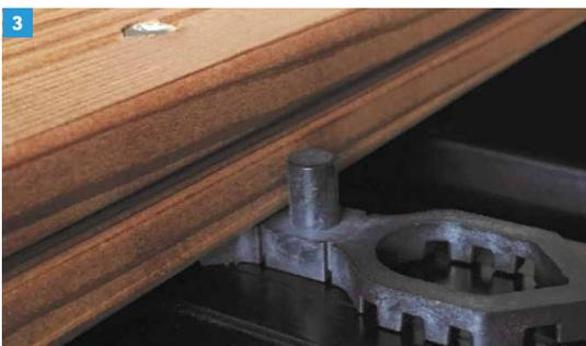
Nun wird immer auf dem Aluminiumprofil ein TerraMaxx® RS-GK als Fugenabstand eingesetzt.
