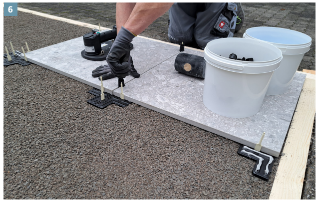
6 Zughauben (schwarz) und Gewindekappen (blau) anbringen und anziehen
