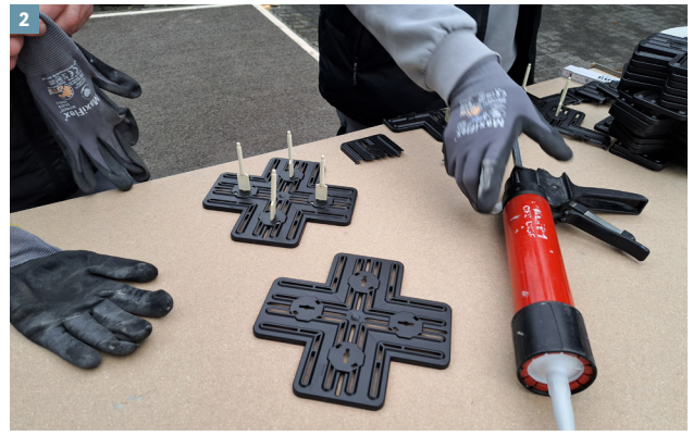
2 Gewindelaschen von unten einstecken
