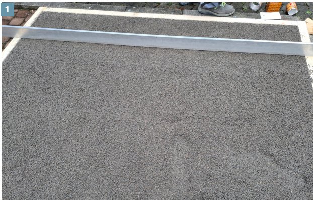
1 Splittbett planeben abziehen
