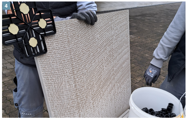
4 AquaDrain® FS Fixierplatten an Belagsrückseiten fixieren
