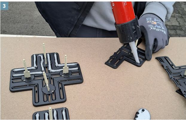
3 DiProtec® FIX-MSP auftragen
