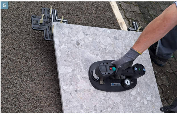
5 Platten auf das Splittbett auflegen und einklopfen
