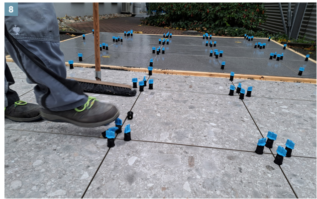
8 Nach Aushärtung des Montageklebstoffes DiProtec® FIX-MSP die Zughauben abstoßen
