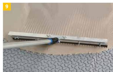
9 Anschließend wird die IndorTec® FLEXBONE-VA mit einer fließfähigen Bodenspachtelmasse wie vom Spachtelmassehersteller angegeben nach Herstellervorgabe verspachtelt.
