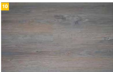
10 Nach Erreichen der Belegereife, der fließfähigen Bodenspachtelmasse, erfolgt unter Einhaltung der Regelwerke und den Vorgaben der entsprechenden Bodenbelags- und Bodenbelagsklebstoffhersteller die Belagsverlegung.
