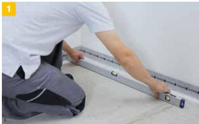
1 Prüfung des Untergrundes auf Eignung und Ebenföchigkeit. Gegebenenfalls sind Ausgleichsarbeiten durchzuführen.
