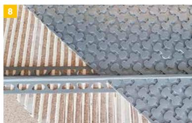
8 An Bauwerkstrenn- und Bewegungsfugen ist die Entkopplungsmatte zu trennen. Die Ausbildung der Fugen erfolgt nach Vorgaben der Regelwerke und Hersteller- verlegevorschriften der entsprechenden fließfähigen Bodenspachtelmassen und des Bodenbelages.
