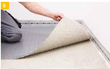
5 IndorTec® FLEXBONE-VA in zugeschnittener Form mit dem Vlies in den Klebstoff einbetten...
