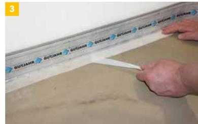
3 Entlang aufgehender Bauteile und Belagsdurchdringungen ist der AquaDrain® RD Randdämmstreifen anzubringen.
