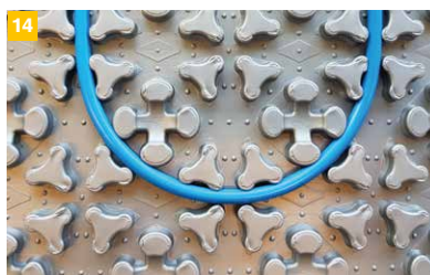
14 Die Heizkabel werden schonend um die Kreuzknochen geführt.
