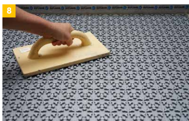
8 IndorTec® THERM-E flächig andrücken oder anrollen.
