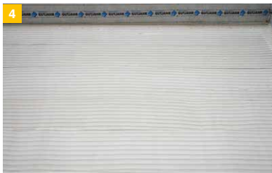
4 Klebstoff mit geeigneter Zahnleiste auftragen.
