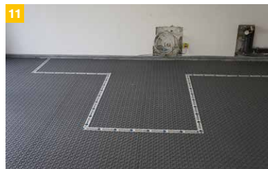
11 Heizfreie Zonen müssen vor Verlegung der Heizkabel gekennzeichnet und ausgespart werden. Diese müssen im beigefügten Verlegeplan skizziert werden (siehe Verlegeplan).
