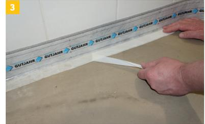
3 Entlang aufgehender Bauteile und Belagsdurchdringungen ist der AquaDrain® RD Randdämmstreifen anzubringen.
