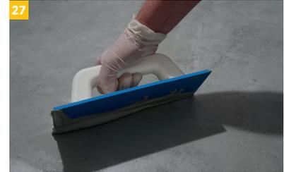
Die Belagsverfugung erfolgt nach Begehbarkeit der Belagsfläche. Aufgrund der fehlenden Saugfähigkeit von Kunststoffmatten ist mit einer 3- bis 4-fach längeren Erhärtungszeit des Klebers gegenüber saugfähigen Untergründen zu rechnen.
