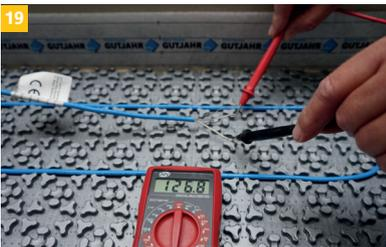
Vor dem Zuspachteln der Matte mit Klebemörtel ist der Gesamtwiderstand des Heizkabels und des Bodenfühlers gemäß Abnahmeprotokoll zu überprüfen und zu protokollieren.
