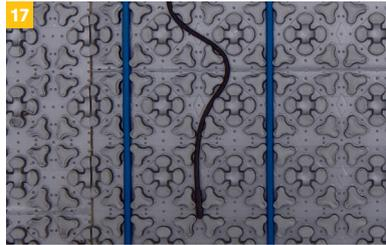
Einlegen des Bodenfühlers zwischen zwei Warmleiter des Heizkabels.
