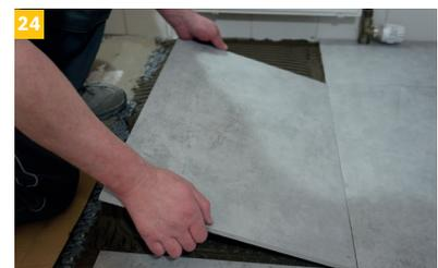
Die Klebemörtelstärke zwischen Oberkante IndorTec® THERM-E und Fliesenunterseite darf 5 mm nicht übersteigen. Mit schwindkompensierten Mittelbettklebemörteln sind Kleberbettstärken bis 10 mm möglich.
