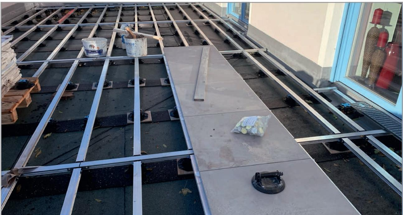
Zusammen mit Gutjahr-Fachberater Ingo Warschawsky entwickelte Fliesenlegermeister Andreas Zimmermann eine passende Drainagelösung, bestehend aus dem leichtgewichtigen Alu-Rahmensystem TerraMaxx RS, den höhenverstellbaren Trockenstelzlagern TerraMaxx TSL, Drain- und Ablaufrosten sowie Sockelprofilen.
