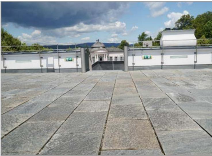
Als Terrassenbelag kam der Naturstein Luserna Gneis zum Einsatz. Problem bei der Verlegung: eine bis zu 40 cm dicke Wärmedämmung. Die lose Verlegung des hochwertigen Belags im Splittbett war deshalb die einzige sinnvolle Lösung. Um den Naturstein dauerhaft vor Schäden zu schützen, empfahl der Steinmetzmeister die Verlegung auf der Flächendrainage AquaDrain T+ von Gutjahr.
