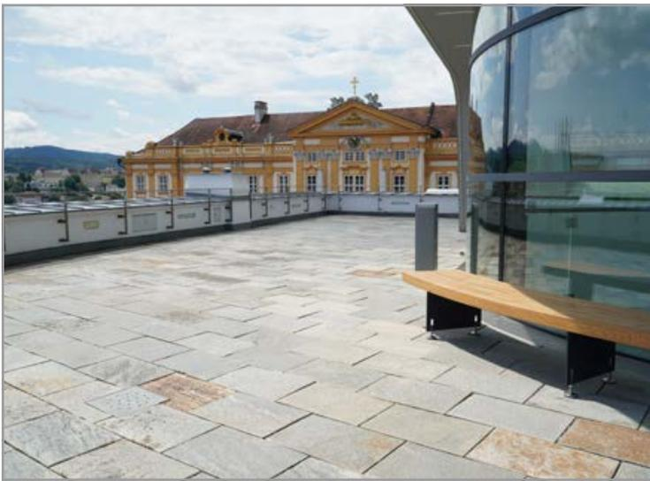
Auf der Dachterrasse von Stift Melk verlegten die Verarbeiter die 16 mm dicken Drainagematten AquaDrain T+ über die gesamte Fläche von 350 Quadratmetern. Darauf kam eine Splittschicht. Der Naturstein Luserna Gneis wurde anschließend lose im Splittbett verlegt, die Fugen wurden mit Splitt verfügt.
