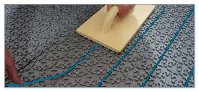
IndorTec THERM-E ist Heizung, Entkopplung und Abdichtung in einem. Dazu hat sie eine äußerst flache Aufbauhöhe von nur 6 Millimetern.
