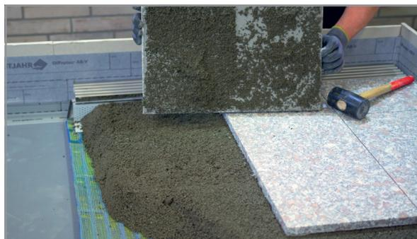
Gutjahr bietet sichere Komplettsysteme für die Verlegung hochwertiger Beläge aus Keramik, Natur- und Betonwerkstein im Außenbereich. Neben Flächendrainagen und Stelzlagern gehören auch zwei Drainmörtel zum Produktprogramm. Steht genügend Aufbauhöhe zur Verfügung, kommt der zementgebundene Drainmörtel MorTec DRAIN-ZE zum Einsatz – zusammen mit Flächendrainage oder Drain-Stelzlager.
