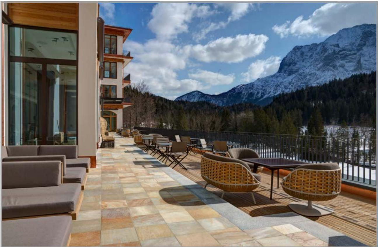
Vor 20 Jahren revolutionierte Gutjahr mit AquaDrain EK die Natursteinverlegung im Außenbereich. Denn der schöne Anblick der hochwertigen Beläge war früher oft nur von kurzer Dauer: Feuchtflecken, Ausblühungen und Frostschäden ließen den Belag schnell unansehnlich werden. Inzwischen sorgt die Kombination aus Drainmörtel und spezieller Flächen- drainage für die optimale Entwässerung – auch bei besonderen Bauwerken.
