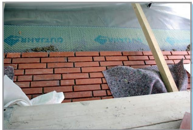
Beim Neubau des Pfarrzentrums St. Konrad in Neuss wurde die klassische Bauweise im wahrsten Sinne umgedreht: Klinkersteine wurden nicht nur an der Fassade, sondern auch auf den geneigten Dachflächen eingesetzt. Die Gutjahr-Flächendrainage AquaDrain HU-EK dient hierbei als zweite Entwässerungsebene.
