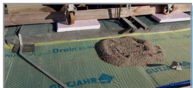
Sechs Jahre lang dauerte die Sanierung der Neuen Nationalgalerie in Berlin. Die Arbeiten betrafen auch den Außenbereich um das Gebäude: Hier wurden sämtliche Natursteine ausgebaut, aufgearbeitet und neu verlegt – diesmal auf einer Flächendrainage. Die Herausforderung: Das Gefälle lag deutlich unter den bautechnisch empfohlenen 2 %. Gelöst wurde sie mit AquaDrain T+ in 16mm.
