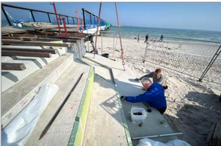
Auf der neuen Betonkonstruktion führt eine breite Rampe zu den Schiffsanlegern. Die rund 200 Quadratmeter große Treppenanlage mit massiven Winkelstufen aus Beton bildet den Übergang vom Strand und vom Seebrückenvorplatz auf die Brücke.
