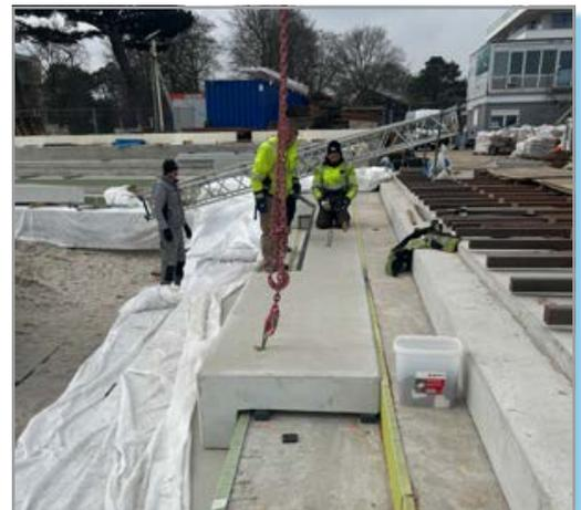
Bei der Stufenanlage in Scharbeutz kam die Stufendrainage AquaDrain SD von Gutjahr zum Einsatz. Sie schützt die Winkelstufen vor Schäden durch Regen und Meerwasser. Denn aufgrund der starken Beanspruchung war eine zuverlässige Entwässerungslösung unerlässlich.
